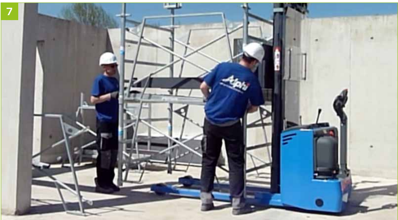
- Mettre en place les planchers de travail dans la tour.
