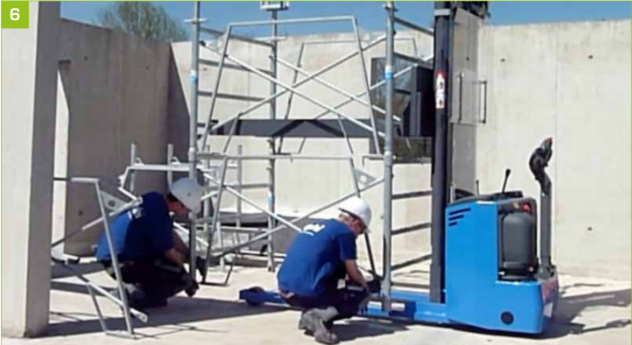
- Assembler les garde-corps : s'assurer du verrouillage des tétons basculeurs (automatique).
